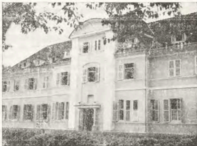
A fachada do Hospital Arquidiocesano, em 1936, criado com a instituição da “Santa Casa”.
